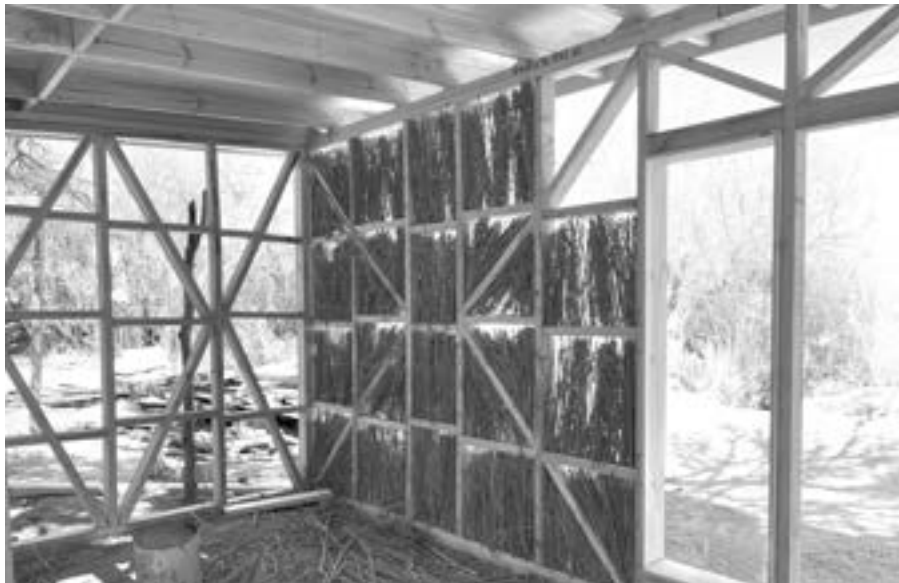
Figura 5. Proceso de relleno de tabique con brea, previo a ser revocado con tierra. Fuente: Elaboración propia, 2024.
