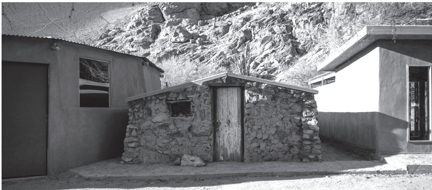
Figura 7. Fotografía vivienda vernácula restaurada, incorporando refuerzo de muros y reemplazo de cubierta. Fuente: Elaboración propia, 2024.
