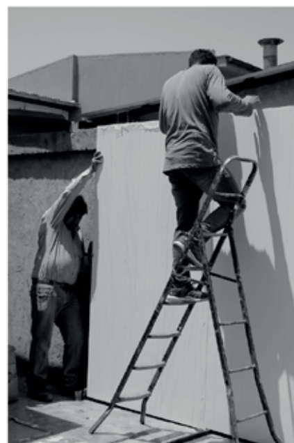
Estrategia constructiva y proceso de montaje. Colección propia.
