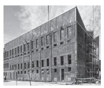
Figura 8. El Campus Creativo Universidad Andrés Bello, Schmidt Arquitectos, genera una ampliación superior contrastante recuperando el edificio con una cubierta de tipo industrial contemporánea coherente al uso anterior. Imagen intervenida. Fuente: www.campuscreativo.cl
