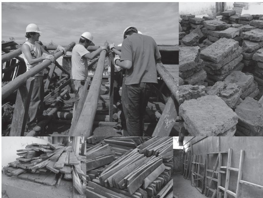
Figura 4. Desmantelamiento y clasificación de materiales en una casa por demoler en la Zona Típica de Chanco. Fotografías: Carmen Gómez Maestro.
